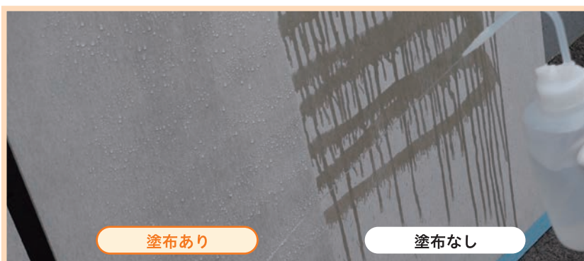
コンクリート表面のはっ水状況
